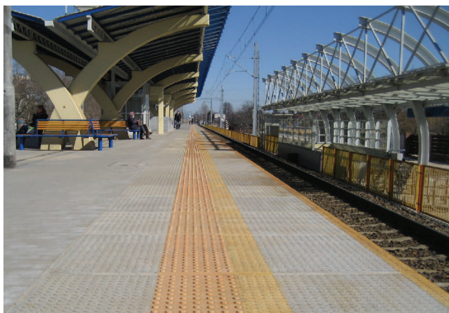
Rys. 6. Oddana w 2014 roku nowa stacja pasażerska Ursus Niedźwiadek [fot. P. Gondek]
