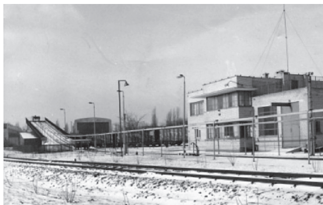
Rys. 3. Badawcza górkę rozbiegową wraz z budynkiem systemu sterowania [fot. archiwum IK]
