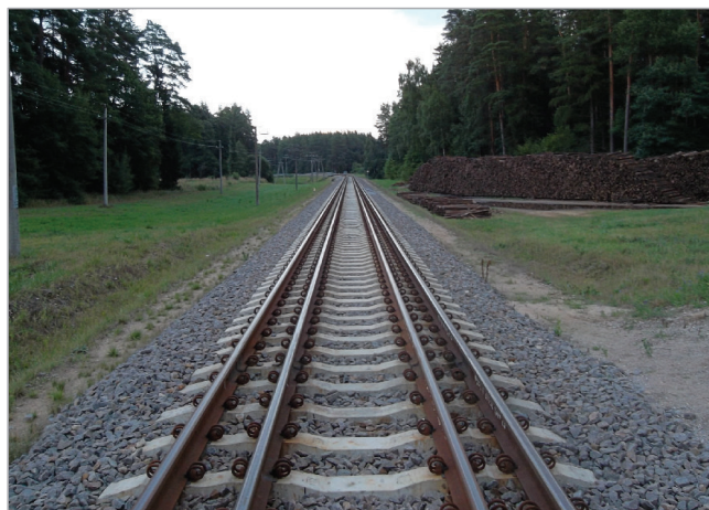
Rys. 4. Tor spleciony na linii Rail Baltica na odcinku Szestokai – Mockava [34]
