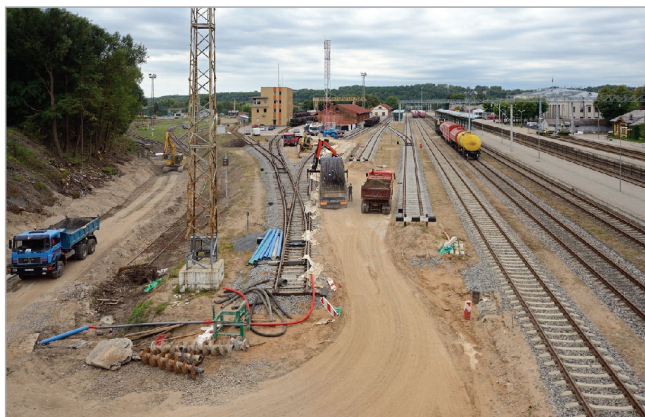
Rys. 5. Modernizacja stacji Kowno [15]
