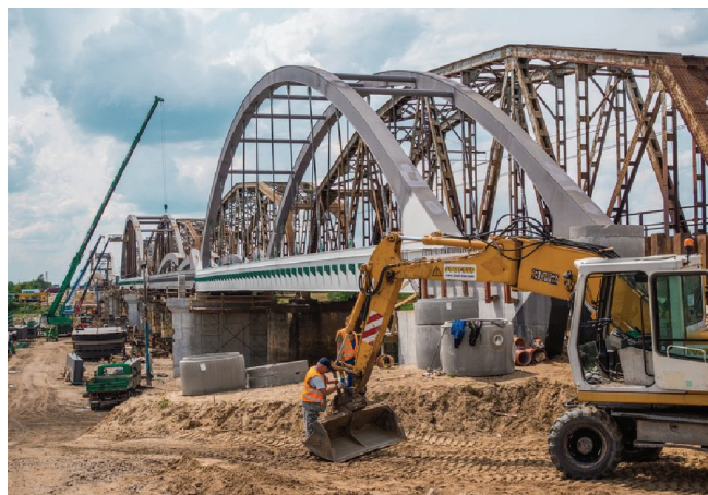
Rys. 2. Budowa nowego mostu na Bugu [27]
