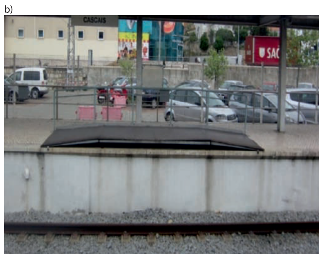
Rys. 5. Peron ze zmienną wysokością (a) [fot. P. Brona] oraz z podwyższeniem (b) na stacjach w Portugalii [1]
