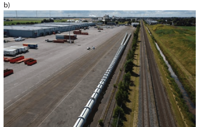
Rys. 17. Europejskie Centrum Hyperloop (EHC) w Groningen [49]: a) budynek administracyjny, b) tor wraz z rurowym systemem zwrotnicowym technologii Hyperloop
