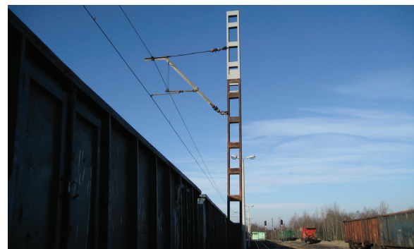
Rys. 5. Konieczność podniesienia sieci trakcyjnej przez wydłużenie (nadspawanie) konstrukcji wsporczych [fot. P. Gondek]
