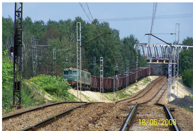
Rys. 1. Przykład deformacji ciągłej (linia nr 133 DG Ząbkowice – Kraków, podg. Dorota – Sosnowiec Maczki; szkody KWK „Kazimierz – Juliusz”) [fot W. Bała]
