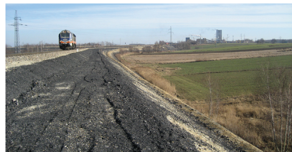
Rys. 7. Coraz większa zajętość terenu (konieczność wykupu gruntów) na skutek ciągłego osiadania nasypu i konieczność podnoszenia niwelety toru [fot. P. Gondek]
