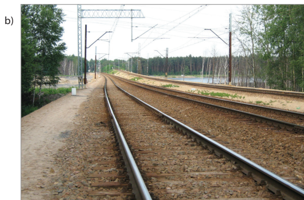
Rys. 9. Szkody górnicze KWK „Kazimierz – Juliusz”: a) linia nr 133 Dąbrowa Górnicza – Kraków, szlak podg. Dorota – Sosnowiec Maczki przed rektyfikacją niwelety torów; b) linia nr 180 szlak podg. Dorota – Mysłowice Brzezinka po rektyfikacji niwelety torów [fot W. Bała]
