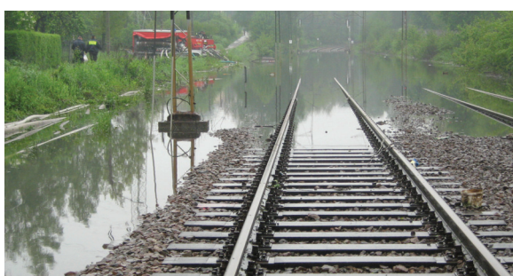
Rys. 8. Zalewisko w obszarze niecki obniżeniowej – powódź 2010 r. (linia nr 139 szlak Katowice Brynów – Katowice Ligota) [fot W. Bała]
