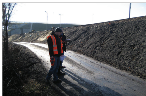
Rys. 10. Przykład stopniowej reprofiliacji nasypu kolejowego (posterunek odgałęźny Bzie Las na linii kolejowej nr 24 Bzie Las – Pniówek) [fot. P. Gondek]
