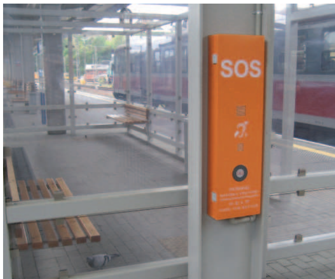
Rys. 2. Przykład panelu łączności z obsługą dworca w przypadku potrzeby udzielenia pomocy osobie niepełnosprawnej [fot. autora]
