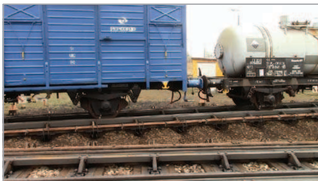
Rys. 14. Odpręg złożony z dwóch wagonów 2-osiowych na hamulcu odstępowym [fot. J. Tyszkowski]
