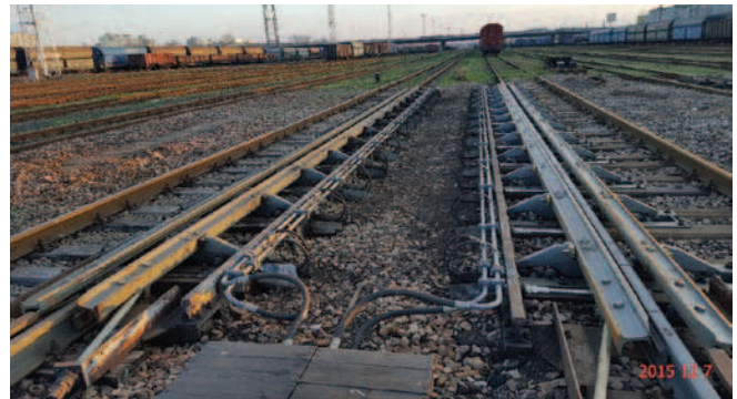
Rys. 4. Hamulce docelowe w torach kierunkowych (II pozycja hamowania) [fot. J. Tyszkowski]
