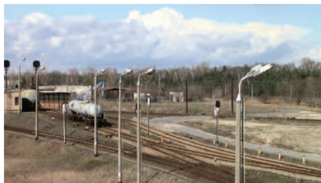
Rys. 1. Widok na górkę rozrządową stacji Warszawa Praga [fot. J. Tyszkowski]
