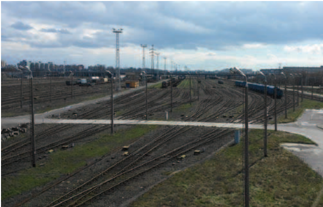
Rys. 2. Strefa podziałowa i tory kierunkowe stacji rozrządowej Warszawa Praga [fot. J. Tyszkowski]
