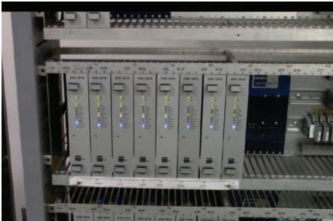
Rys. 8. Elementy modułu sterowania hamulcami torowymi SHT-1M [fot. J. Tyszkowski]
