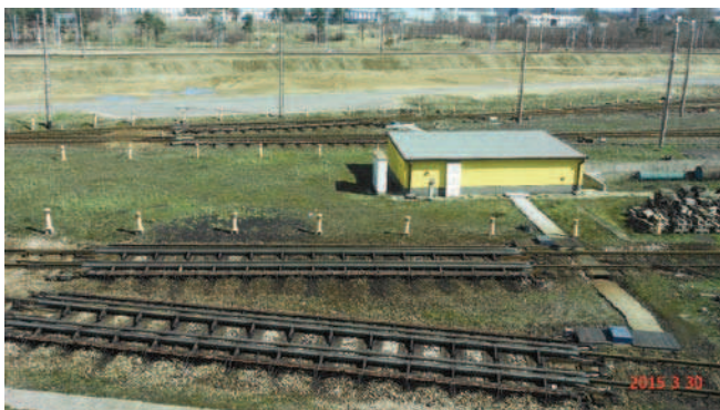
Rys. 11. Widok z nastawni stacji rozrządowej Warszawa Praga na strefę hamulców odstępowych oraz maszynownię [fot. J. Tyszkowski]
