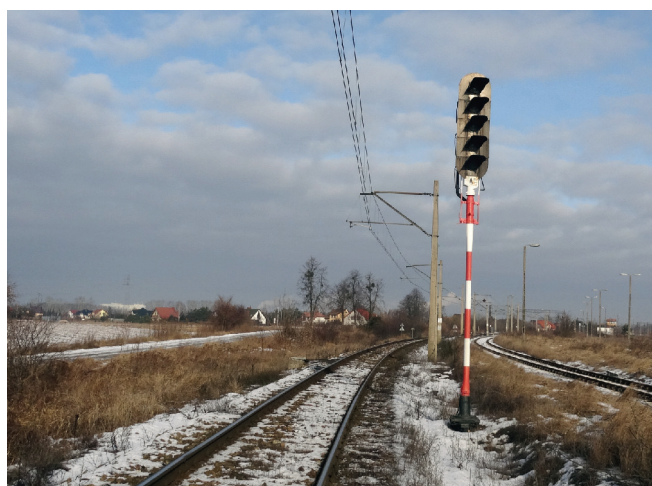
Rys. 1. Sygnalizator przytorowy świetlny pięciokomorowy [fot. K. Olszewski]
