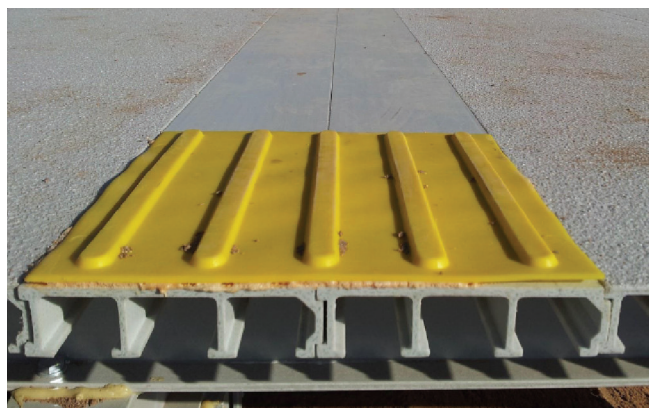
Rys. 11. Konstrukcja nawierzchni peronu [16]; fot. Ольга Шукайло
