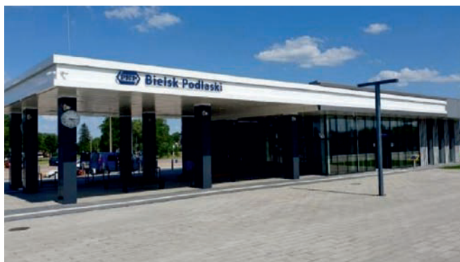
Rys. 10. Dworzec kolejowy Bielsk Podlaski [22]
